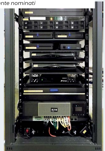
Sala tecnica pulita. Fronte e retro del rack, con cavi disposti in modo ordinato e dispositivi accuratamente nominati
